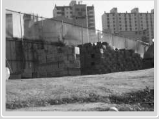
4 구리시 인창동 공사현장
