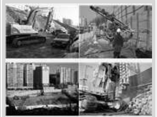
2 홍은동 사업장 공사현장
