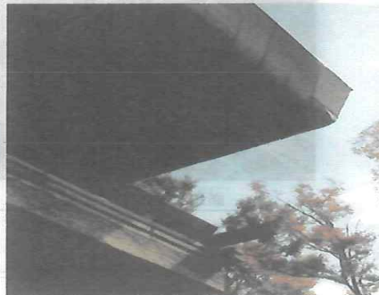
写真-3.3 改修前の南西側出隅部
