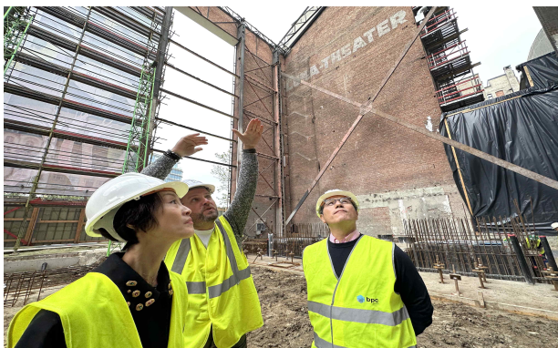
벨기에 카날 풍피두 센터 공사 현장 방문
